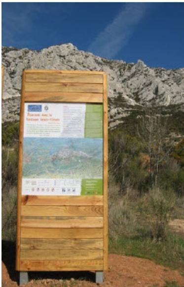
Sébastien Drochon (Coop Provence Forêt) a assuré un suivi de ces panneaux et confirme qu'il n'a pas été décelé de problèmes sur le bois en tant que tel. Par contre le bois non séché peut provoquer, outre l'encrassement des machines, des cisaillements et la déformation des tôles fixées sur ces panneaux.
