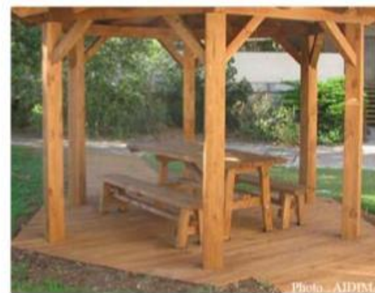
Pergola et aménagement extérieur en pin d'Alep traité autoclave Espagne – 2014 (réalisation et photo AIDIMA)
