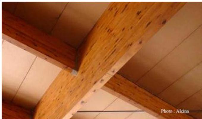
*À gauche : charpente en bois lamellé collé pin d'Alep, pin sylvestre et pin noir
