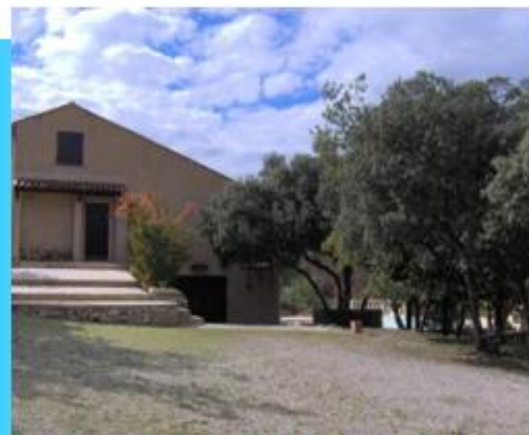
Pas de dégâts
