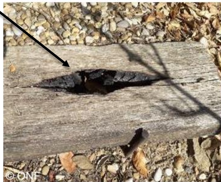
Le début de combustion sur ces deux exemples différents de marches en bois illustre la possibilité d'atteinte de tout élément en bois du fait des projections de brandons.
