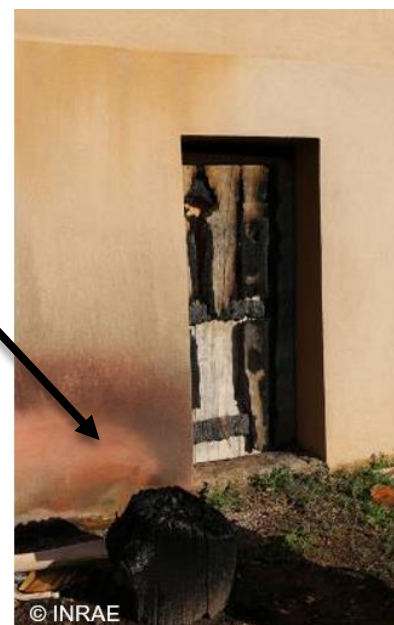
Stockages divers dont la combustion a impacté la façade et s'est propagée à une porte et une gouttière PVC.
