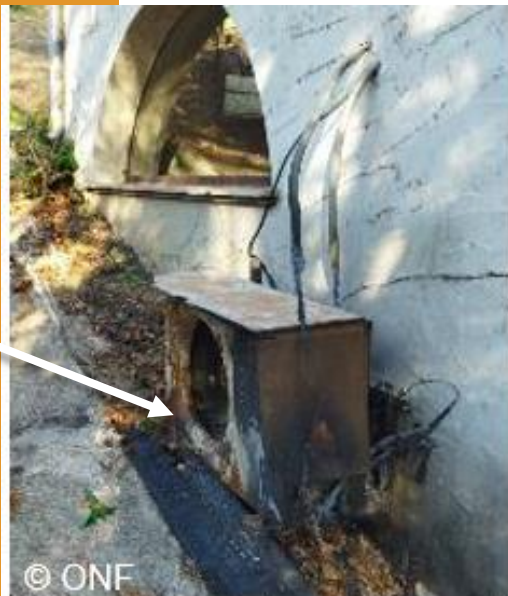
© ONF Nombreux blocs de climatisation impactés
