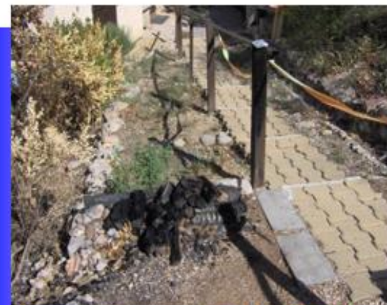
Dégâts matériels périphériques
