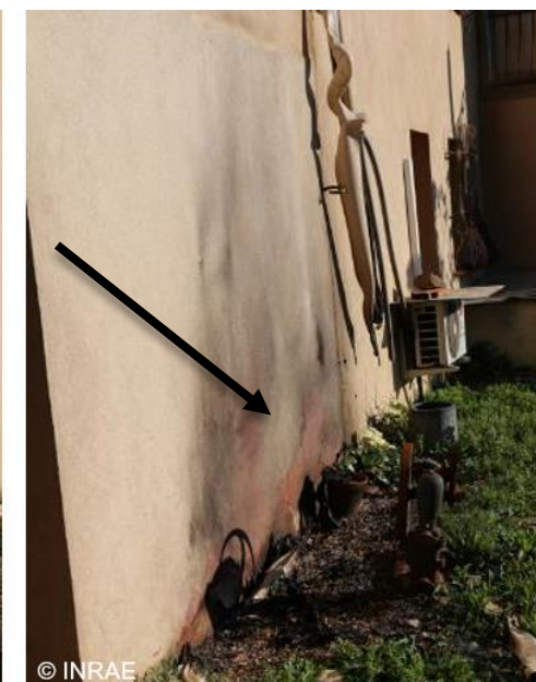
Stockages divers dont la combustion a impacté la façade et s'est propagée à une porte et une gouttière PVC.
