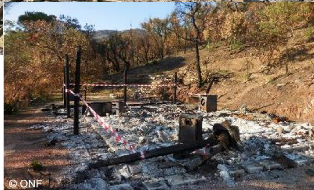
Bâtis légers entièrement détruits.
