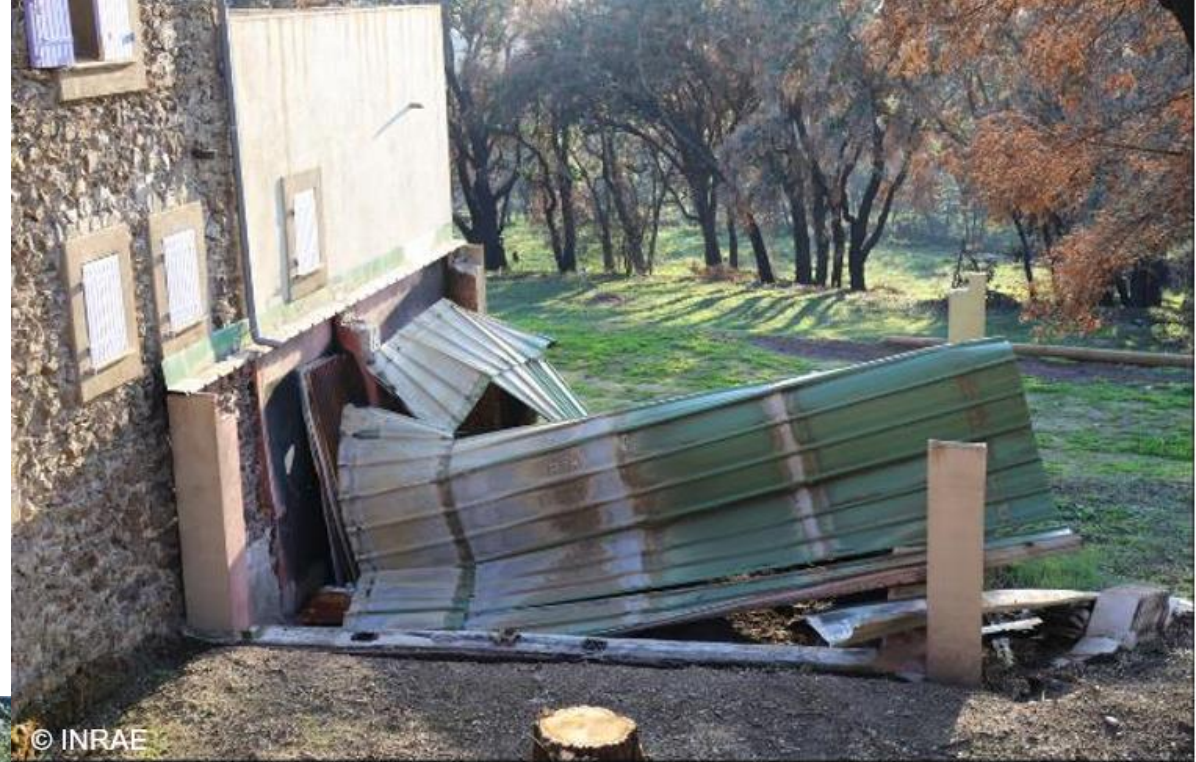
Appentis avec poutres apparentes ; feu non propagé à l'habitation.
