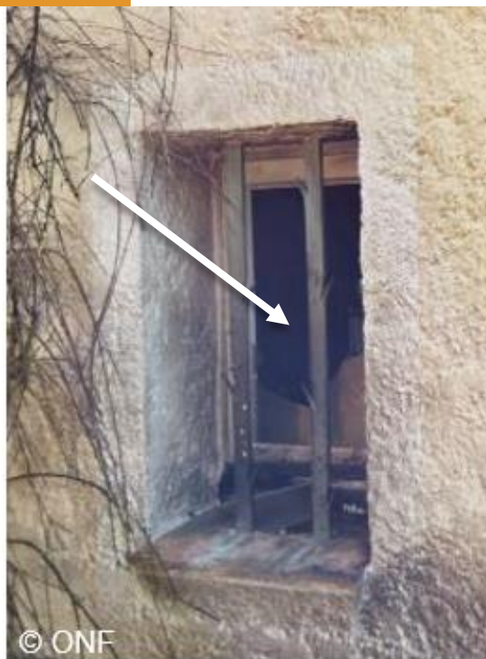
© ONF © ONF Les ouvertures en verre non protégées par des volets sont des points de fragilité
