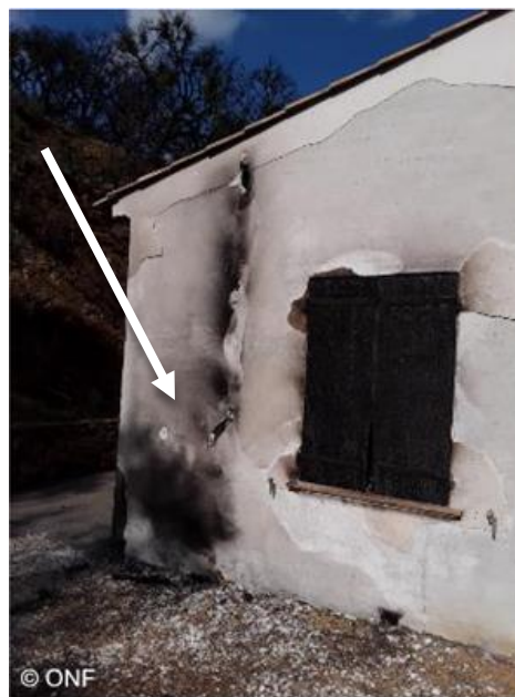
Mobilier de jardin dont la combustion a impacté la façade.
