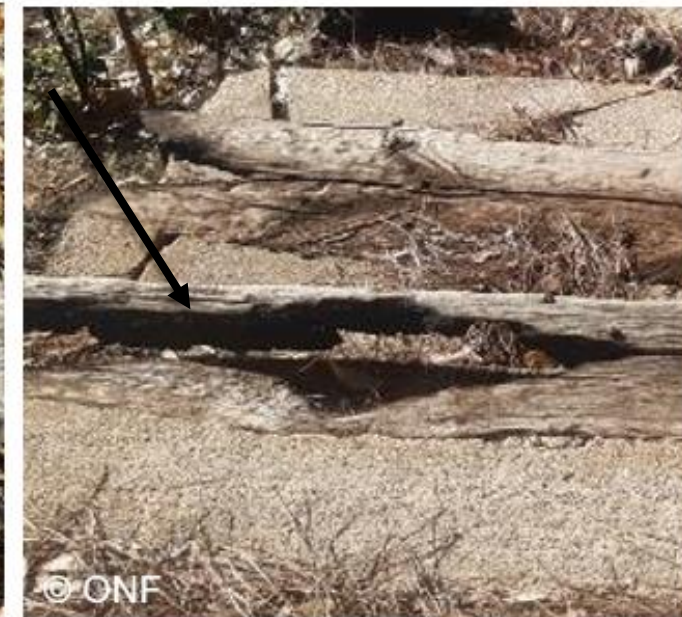
Le début de combustion sur ces deux exemples différents de marches en bois illustre la possibilité d'atteinte de tout élément en bois du fait des projections de brandons.
