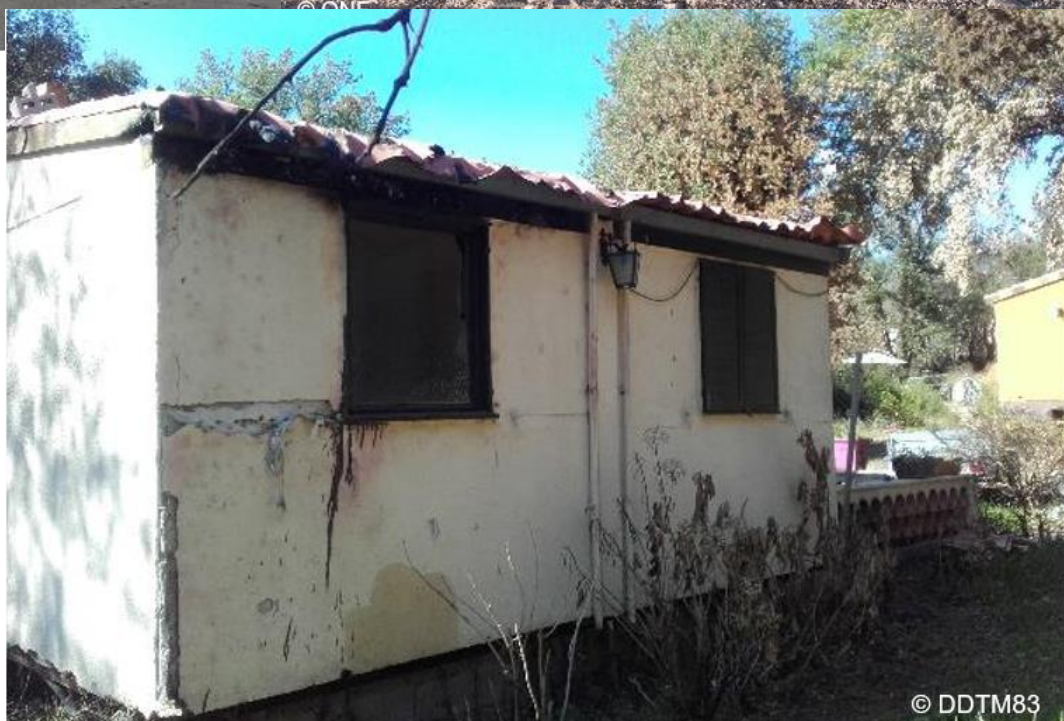
Bâti d'habitation en « préfabriqué ».
