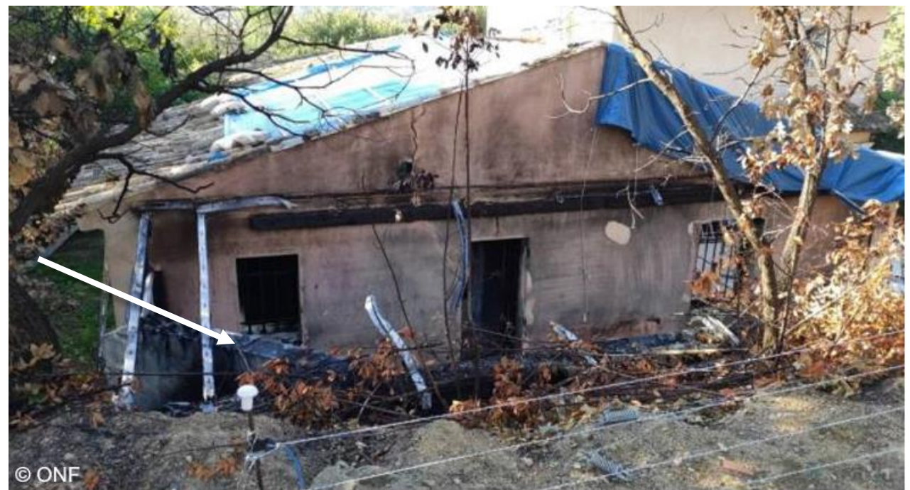
Appentis en bois dont la combustion a propagé le feu à l'intérieur de la maison
