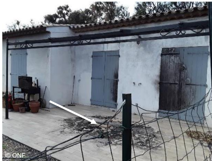
Mobilier de jardin dont la combustion a impacté la façade.
