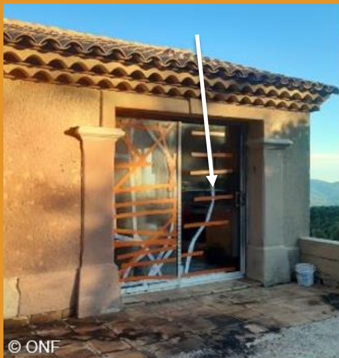
© ONF © ONF Les ouvertures en verre non protégées par des volets sont des points de fragilité
